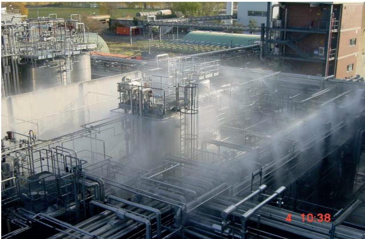
Bild: Sprühflutlöschanlage im Einsatz (Testbetrieb)
